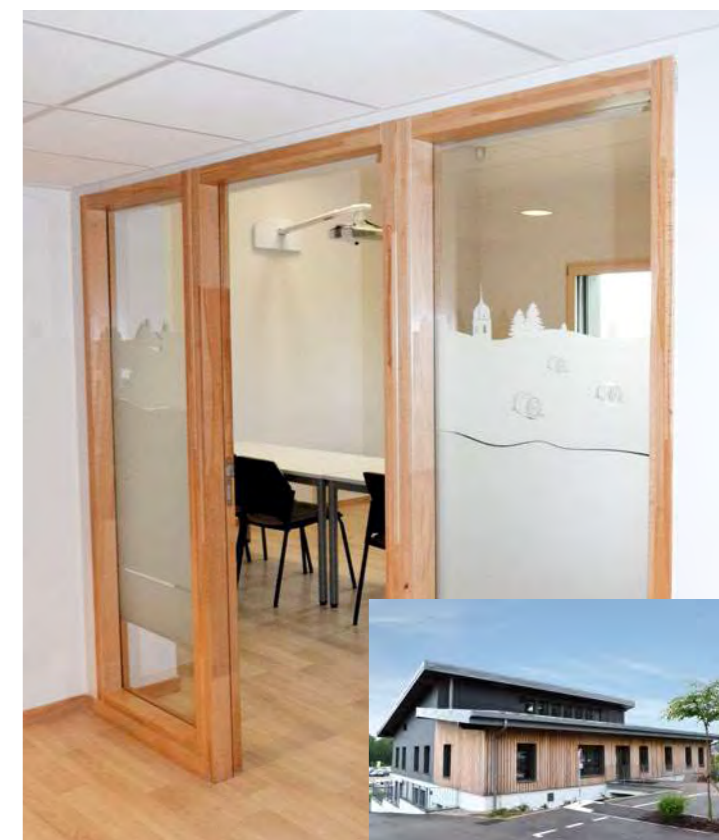
Bâtiment de la communauté de communes des portes du Haut-Doubs à Valdahon (25) Architecte : ARCHI+TECH Menuiseries intérieures en hêtre abouté
