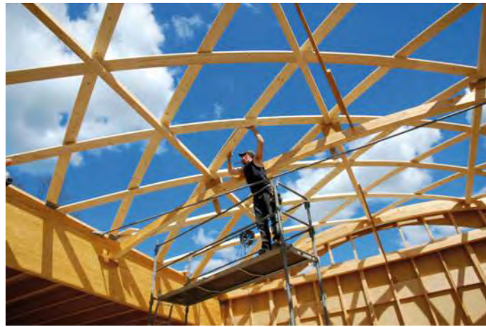
Groupe scolaire de Saint-Maurice-Colombier (25) Architecte : Michèle BOURGEOIS architecte Charpente bois massif, technique de coque nervurée
