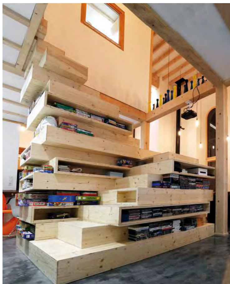
Rénovation et requalification d'une église à Tavey (70) Architecte : BELUGA studio Escalier / rangements en panneau 3 plis
