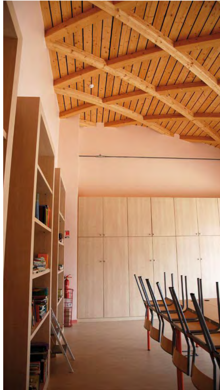
Groupe scolaire de Saint-Maurice-Colombier (25) Architecte : Michèle BOURGEOIS architecte Charpente bois massif, technique de coque nervurée
