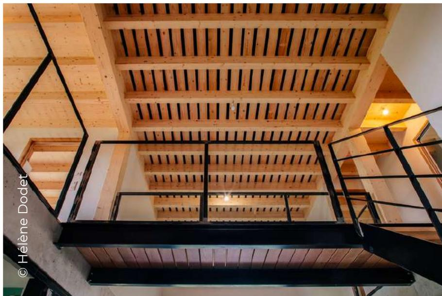
Rénovation complète d'une ancienne ferme en maison individuelle. La bâtisse existante est en moellon de pierre avec une charpente traditionnelle en bois et une couverture tuile. Après avoir créé de nouvelles ouvertures dans les murs pierre, des planchers intérieurs sont créés dans la partie grange pour venir en exploiter les volumes. Les deux travées latérales sont occupées sur deux niveaux. Elles sont séparées par un espace central en double hauteur qui accueille la pièce de vie principale.
